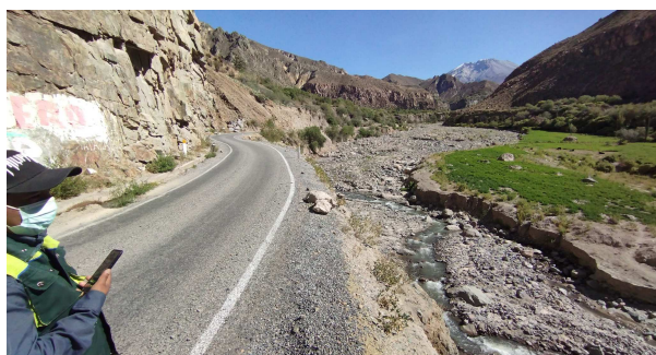
via ubinas matalque, via cerca a precipicio con riesgo de colapso de talud
